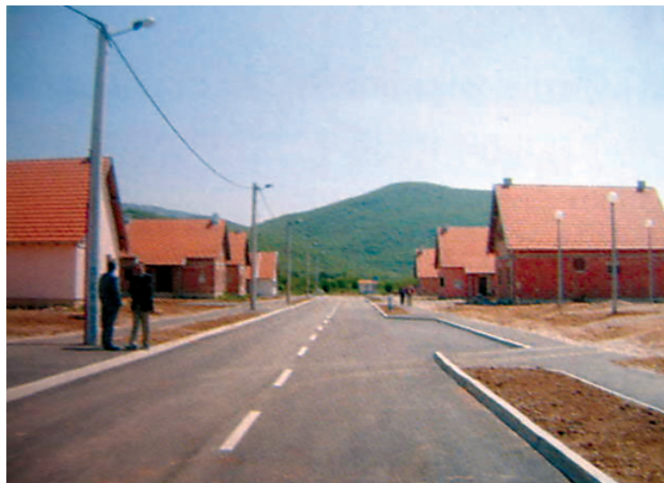
Obnovljene kuće u Gračacu. Ispražnjene srpske kuće nakon „Oluje“ naselili su najvećim dijelom Hrvati prognani iz BiH. Da bi se omogućio povratak imovine vlasnicima, za te ljude Republika Hrvatska gradi kuće.
